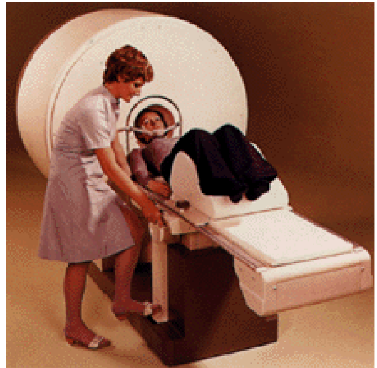
Původní CT skener (pouze hlavy) z roku 1974
